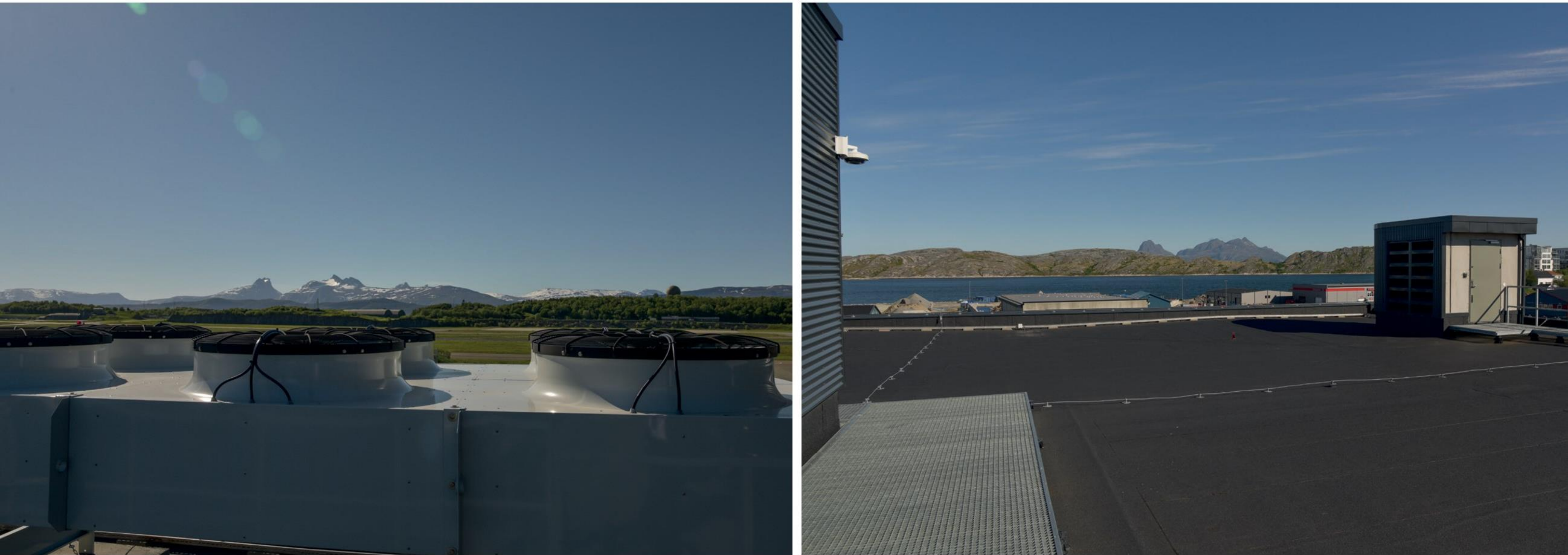
På kontrolcentrets tag er der kølesystemer til elektronikken, men der er også plads til en tagterrasse, fortæller Centrets leder Geir Ove Heir.
