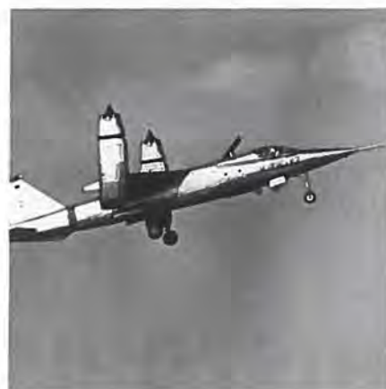
VJ-101 i VTOL landingsfase. Se lemmerne til indsugningen over de to jetmotorer, der er indbygget i kroppen, lige bag cockpittet.
