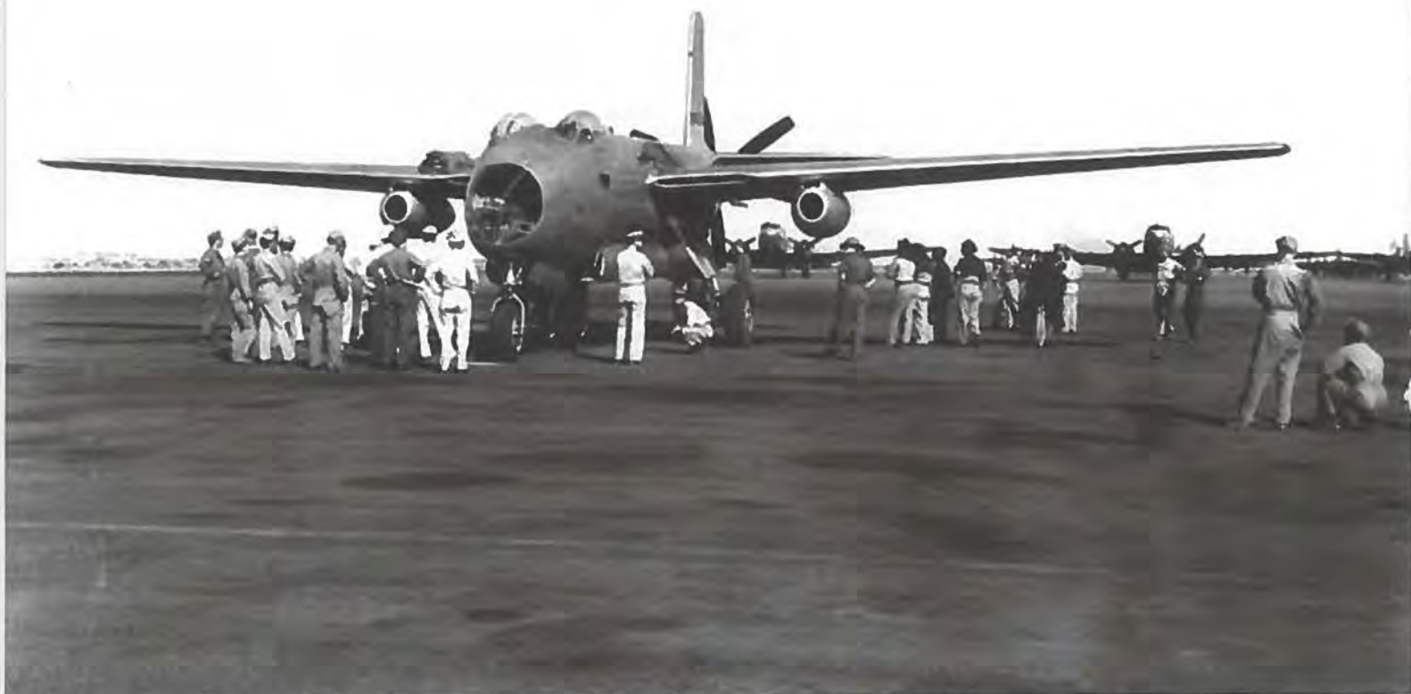
Første prototype af XB-42 blev under testforløbet til supplerung af stempelmotorerne afprøvet med to små jetmotorer, der var monteret under vingerne.
