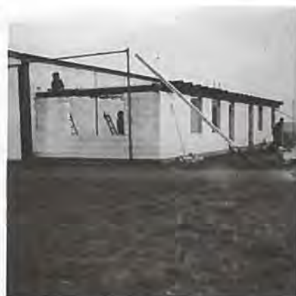
Hangaren er færdig. Klubhuset bygges 1970.
