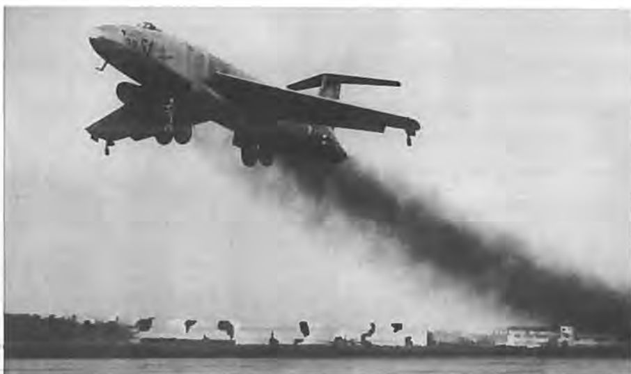
Martin XB-51 starter på sin første flyvning. De dobbelte hovedhjul trækkes op i kroppen. Der er støttehjul i vingetipperne a'la Boeing B-47, B-52 o.a.
