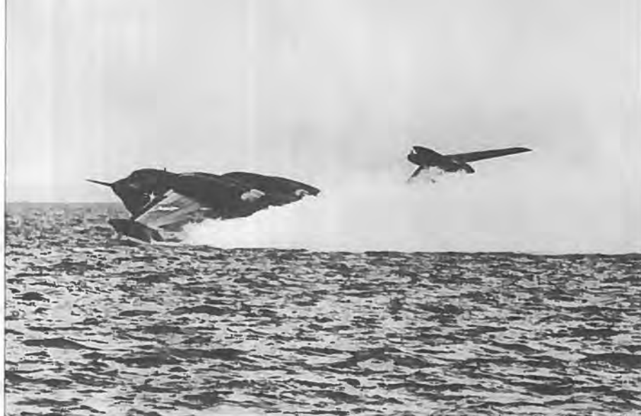
Det ultrahøjt placerede højderor var en nødvendighed for manøvreringen for eksempel under start og landing. Men det var desværre hovedårsagen til at en af prototyperne fatalt forulykkede.
