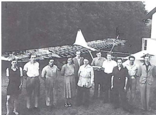
Birkerød Flyveklubs første nybygning, en SG-38 (senere OY-67) klar til beklædning af vingerne.
