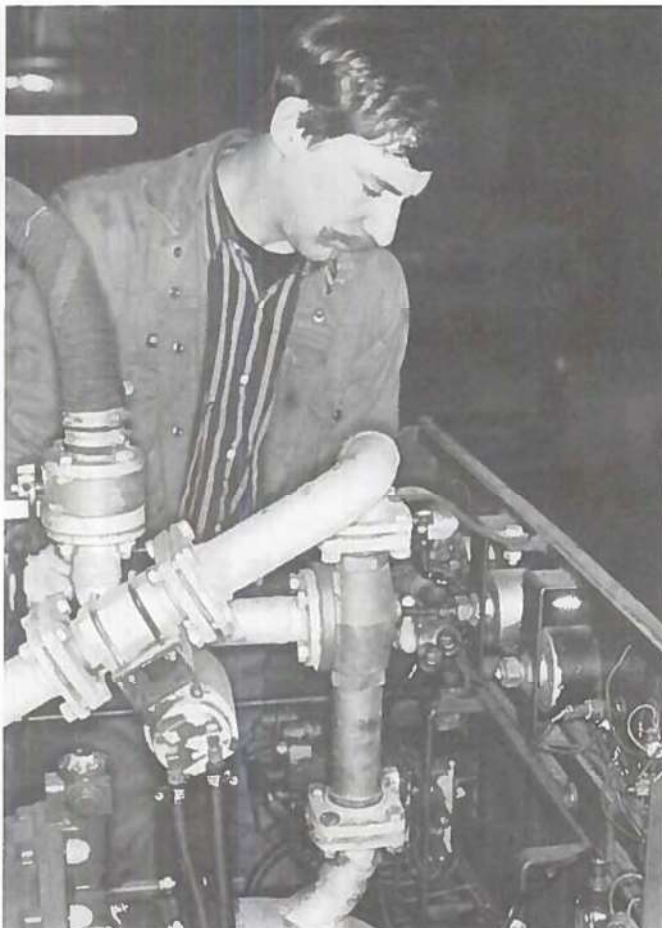
Enhver brandmand i Flyvevåbnet vil nikke genkendende til denne samling rør og metal: Det er pumpen bagest i U-2 slukningskøretøjet.
