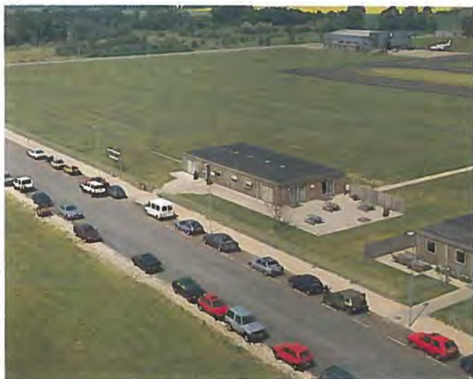
Danish Air Service's undervisningsbygning i Roskilde Lufthavn ligger i et inspirerende luftfartsmiljø og danner samtidig de gode rammer om de mange aktiviteter.
