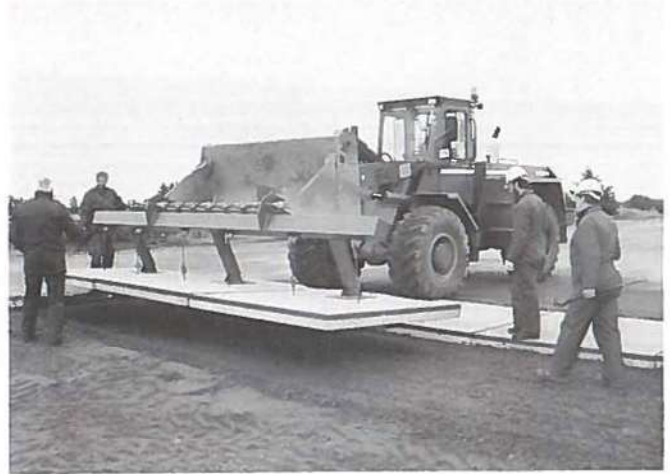
Tre fliser hver på 2 x 2 meter og med en vægt på ca. 1,3 tons lægges på ad gangen, når underlaget er fast, stampet og fuldstændig jævnt. (Foto: FLV)
