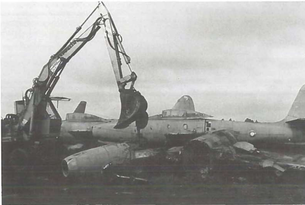
Hovedhjulet forsøges knækket af med gravkoen. Det lod sig ikke gøre. Først da man gik frem efter anvisningerne med det »finere« værktøj, gav hjulet efter og lod sig lægge ned.
