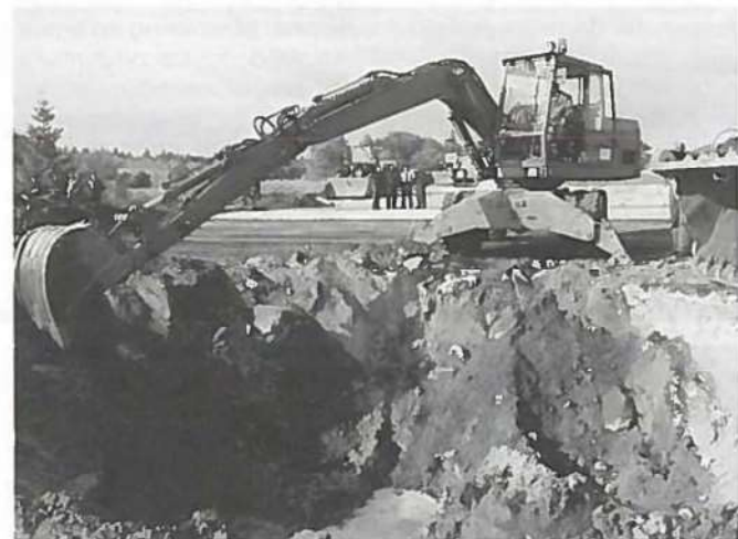
Fra RRR-uddannelsen på FSN Karup. Alt løst materiale skal fjernes fra krateret. (Foto: FLV)
