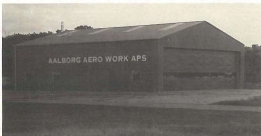
Aalborg Aero Works værkstedsbygning med Danmarks største elektriske hejseport.
