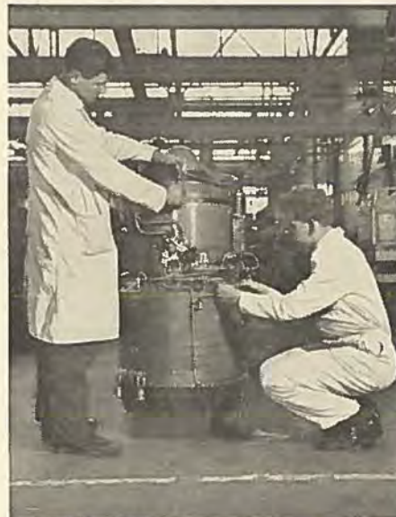
Englands Jetmotor-industri frembringer stadig nye typer som denne Rolls-Royce RB. 162, der har ringe vægt i forhold til sin ydelse.
