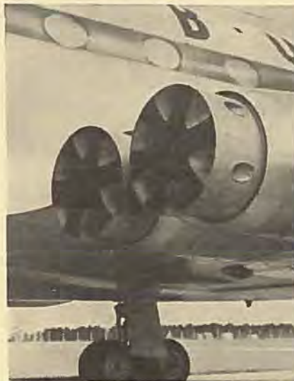
Lyddæmperne på jetfly har kostet hundreder af millioner kroner og er en fortsat økonomisk belastning ved deres vægt.
