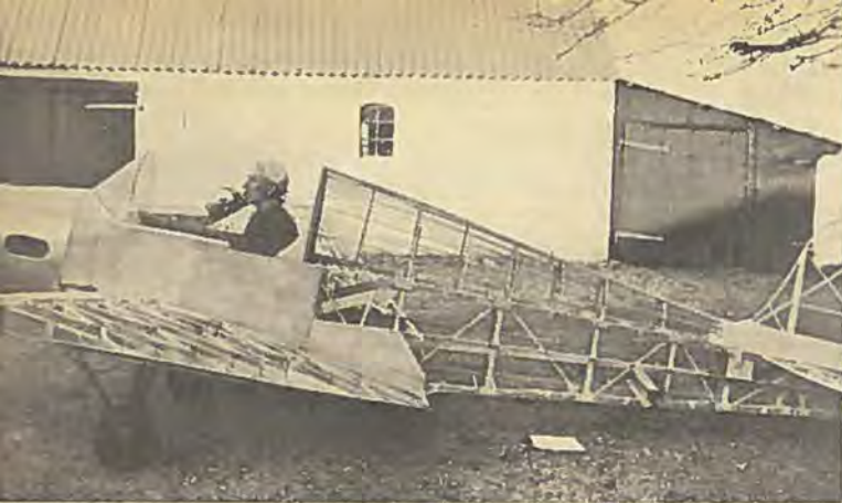
To billeder af maskinen ubeklædt. Man ser tydeligt den lidt usædvanlige konstruktion, som dog både er stærk og let. Det er Arne Hollænder, der sidder i maskinen.
