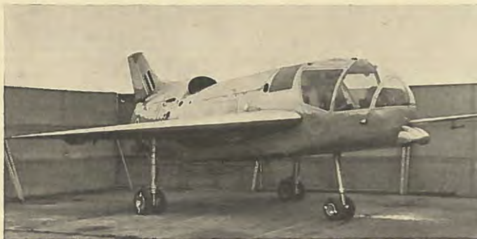
Short SC-1 vil først blive prøvet som normal maskine, dernæst i lodret flyvning og til sidst kommer så overgangene mellem de to flyvetilstande.
