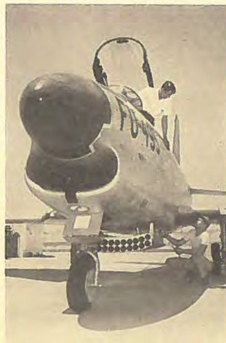
Næsen af en North American F-86D Sabre. Man ser raketterne blive hejst om bord.
