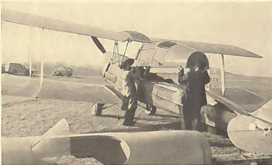
Thrupton Jackaroo — en ombygget Tiger Moth — kan hurtigt ændres fra ensædet landbrugsmaskine til firesædet privatmaskine.
