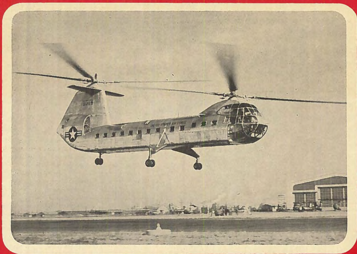
Den kæmpemæssige Plasecki YH-16 Transporter, der er forsynet med to 1650 hk Pratt & Whitney-motorer, og som kan medføre 40 soldater.
