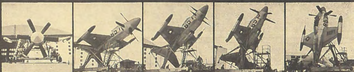
EN SPECIEL KONSTRUERET VUGGE LØFTER XFV-1 fra vandret stilling (for eftersyn og vedligeholdelse) til lodret startstilling.
