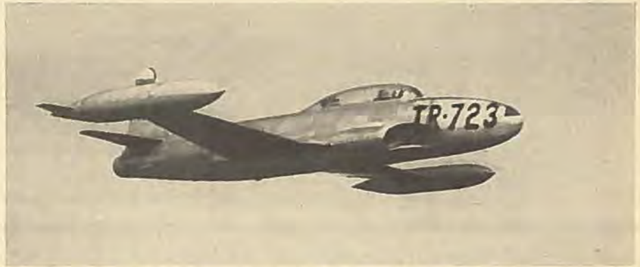
Fra flyvevåbnet har vi modtaget dette fotografi af en af vore Lockheed T-33 træningsmaskiner, som vi fik et antal af i fjor. Det er en tosedet udgave af Lockheed Shooting Star. Tophastighed 960 km/t.
