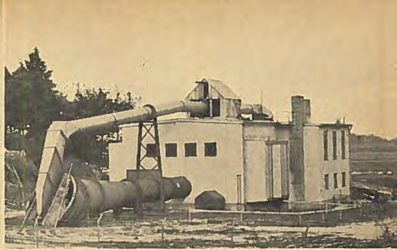
Til venstre ses en tegning af den vindkanal, som North American er ved at bygge i Los Angeles. Til højre ses SAAB-vindkanalen i Linköping. Den ses bagfra med udstødsrøret, hvorfra en del varm luft føres op over taget og påny ledes ind i kanalen.
