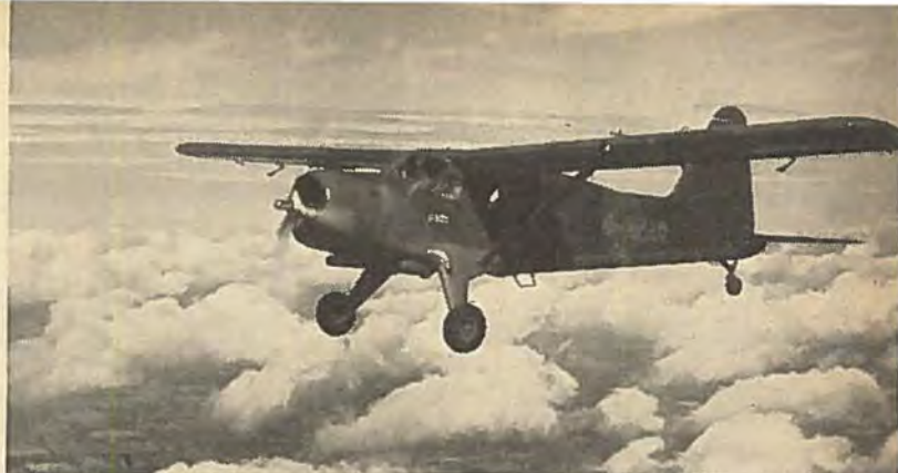
Til venstre Vickers Valiant B Mk. II med Rolls-Royce Avon reaktionsmotorer. — Til højre de Havilland Beaver serie 2 med Alvis Leonides motor.
