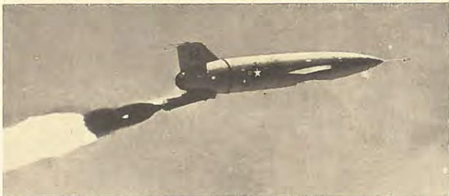
Den 1. oktober trådte den 1. forerløse bombeskadrille i det amerikanske luftvåben i virksomhed. Den er udrustet med Martin B-61 Matador, der startes med raket og ellers flyver på reaktionsmotoren.
