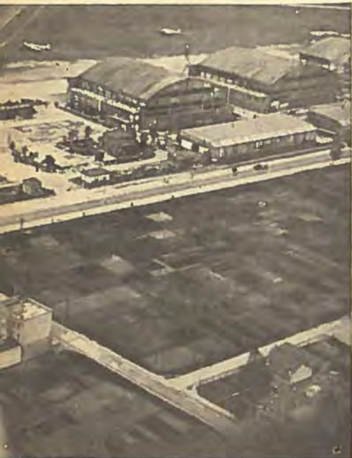
Paris's Lufthavn, Le Bourget. Hangarerne er alle under Reparation efter Krigsbeskadigelser.
