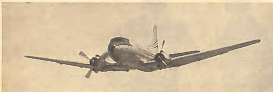
Martin 2-0-2 under den af ICAO foreskrevne Startprøve paa een Motor. Propellen paa den anden Motor er kantstillet.
