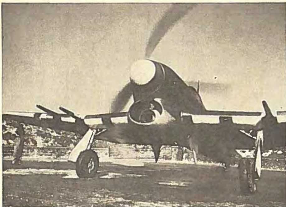
Hawker »Typhoon 1 B.« Dens Udseende er karakteristisk ved den store Luftindforsel for Karburator og Oliekoling midt under Kroppen. Man bemærker den kraftige Bevæbning med 4 Stk. 20 mm Maskinkanoner.
