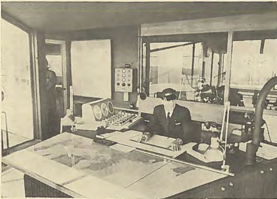
Radiolokale med Pejlanlæg, Pejlkort m. v.
