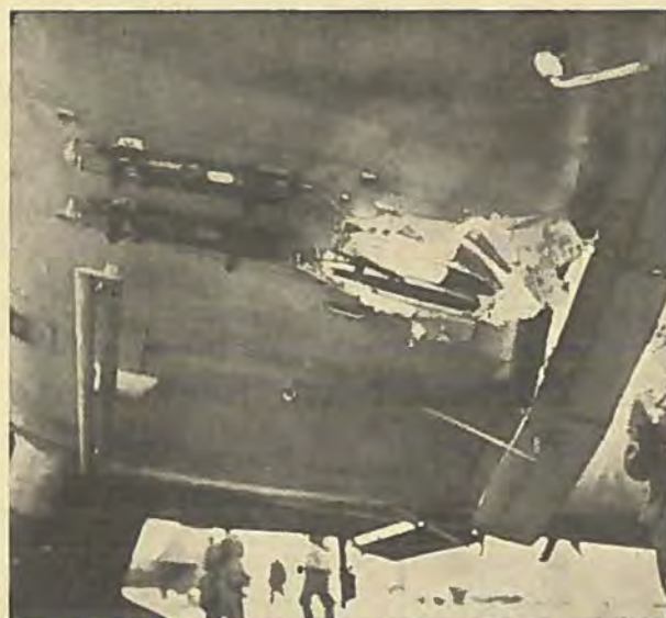
Fig. 2a og 2b. Virkningen af en 20 eller 23 mm Brisantgranat overfor et Ju 87-Bæreplan. (Udgang- og Indgangshul). Foruden at rive Beklædningen op har Sprængstykkerne utvivlsomt beskadiget Bjælken, saaledes at Planets Styrke er forringet. Forsigtig Flyvning har herefter været nødvendig.
