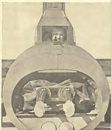
Haletaarnet i Breing B-17F med to Maskingeværer.
