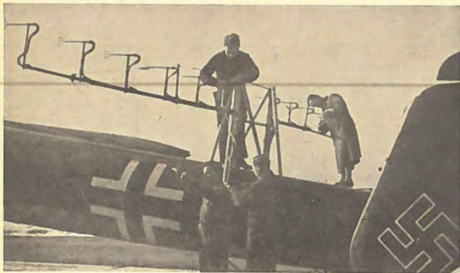
Stativet til Undersøgelse af Luftstrømmens Hastighed og Retning foran Halepartiet.
