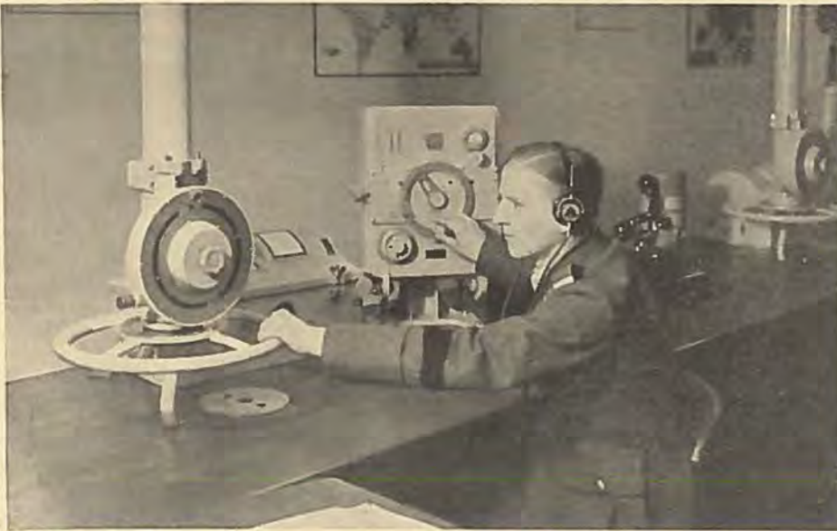
En Telefunken-Pejler i Virksomhed paa en Lufthavns Radiostation.
