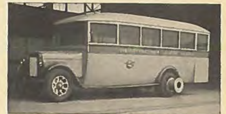
»Aviators« Omnibus med paamonteret Tromle til Spilstart.
