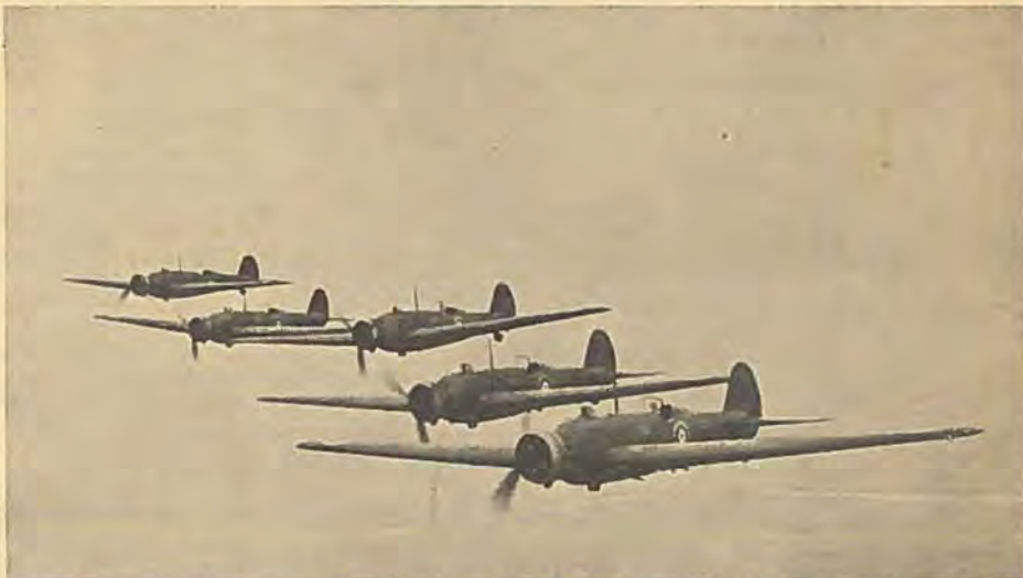
Vickers »Wollesley« Langdistance Bombeflyvemaskiner udstyret med Bristol Pegasus Motor.
