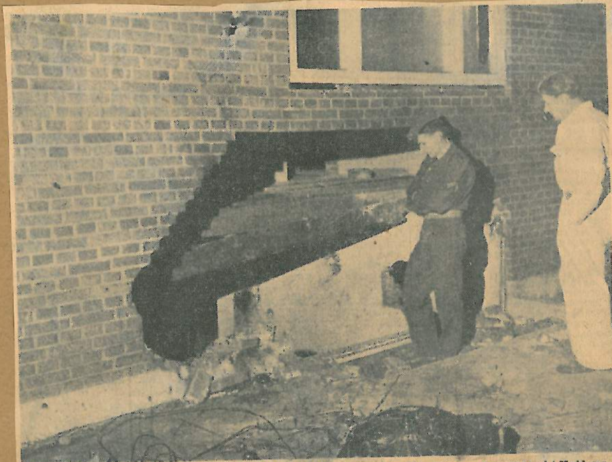
Dette Hul slog Spitfirejageren i Konstruktor Buchwald Basmussens nye Hus. Motoren fortsatte ned i Kælderen, hvor den knækkede Vandreret.
